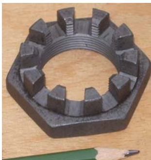
Abbildung 8: die zentrale Kronenmutter M30 x 1,5 mit 10er-Splintteilung (ähnlich ISO 7038 – M30 x 1,5)
